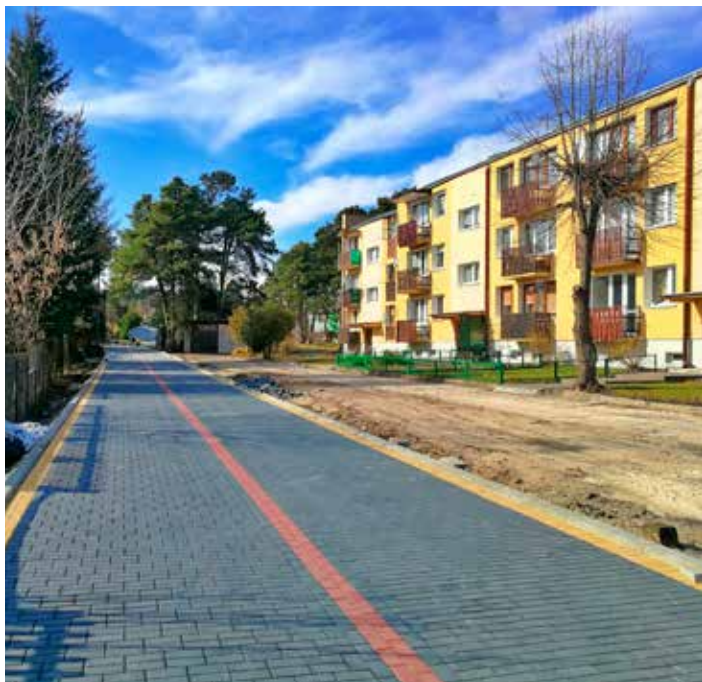
Jedna z 5 przebudowanych ulic w ramach projektu dotyczącego poprawy komunikacyjnej w Woli Uhruskiej.
