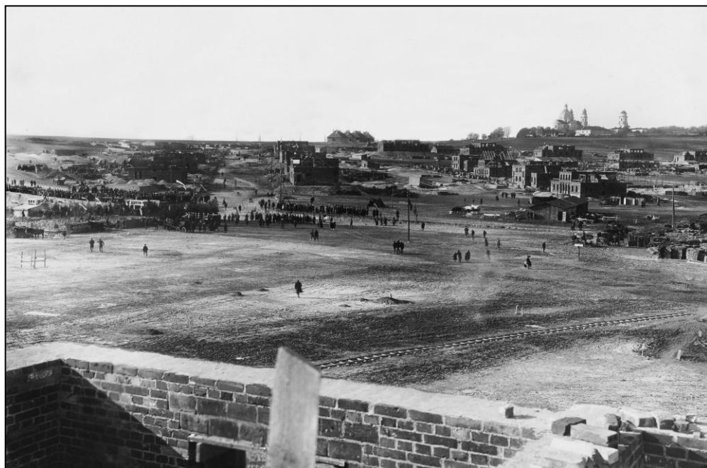
Fot. 12. Fragment budowy osiedla Dyrekcja w Chełmie. Lata 1928/1929. Zbiory Muzeum Ziemi Chełmskiej im. W. Ambroziewicza w Chełmie.
