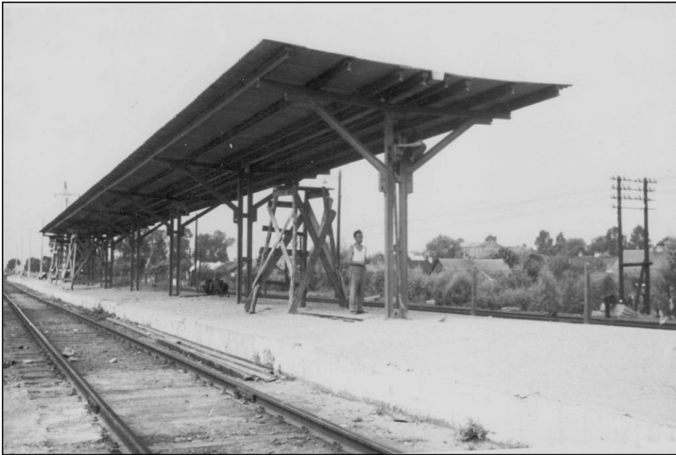
Fot. 27. Budowa przystanku kolejowego Chełm Miasto. Montaż zadaszenia na peronie. Ul. Lubelska. 1959 r. Zbiory prywatne Wiesława Wojasiewicza.
