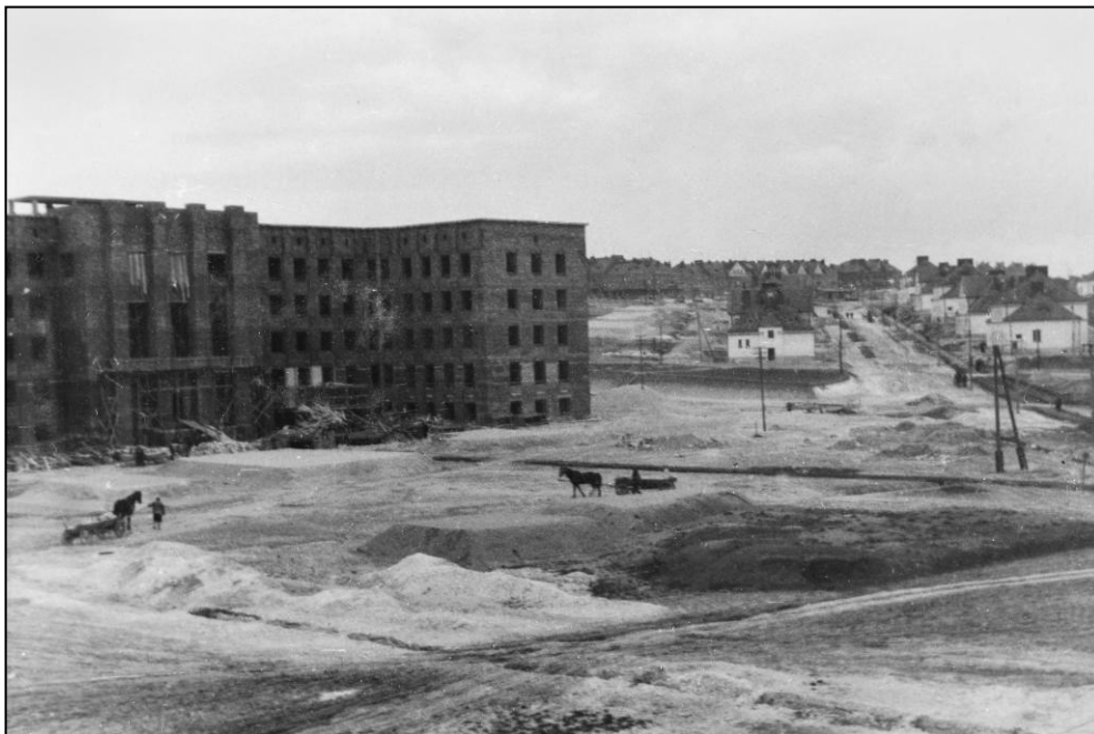
Fot. 16. Widok na gmach Dyrekcji Kolejowej i ulicę Stephensona w budowie. Lata 30. XX wieku. Zbiory Wojewódzkiego Urzędu Ochrony Zabytków w Lublinie Delegatura w Chełmie.
