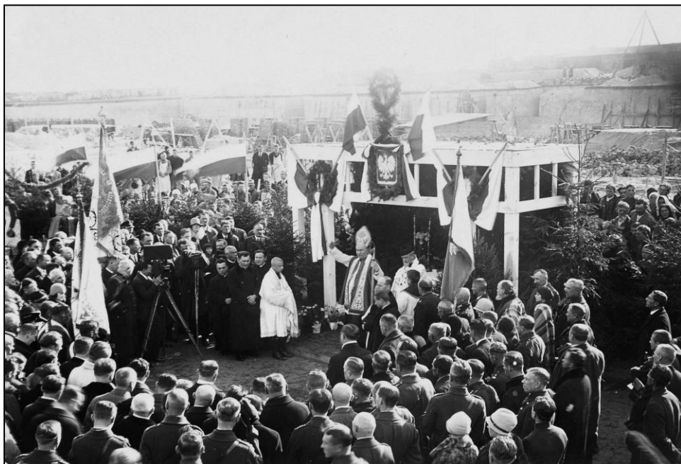
Fot. 11. Wmurowanie kamienia węgielnego pod budowę gmachu Dyrekcji Kolejowej w Chełmie. 22 października 1928 roku. Zbiory Muzeum Ziemi Chełmskiej im. W. Ambroziewicza w Chełmie.
