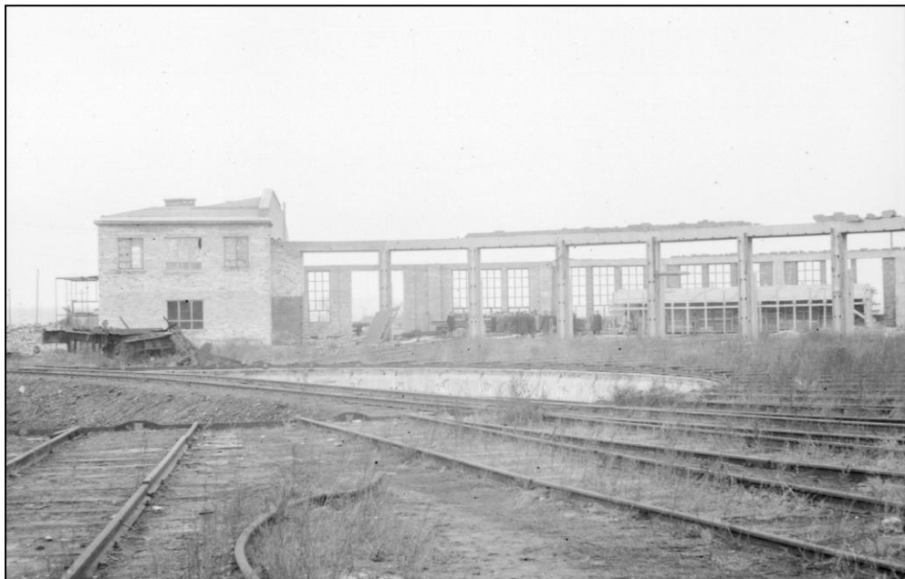
Fot. 23. Parowozownia Chełm zniszczona w wyniku działań wojennych. Odbudowane pomieszczenie dyspozytora. Listopad 1946. Zbiory prywatne Wiesława Wojasiewicza.
