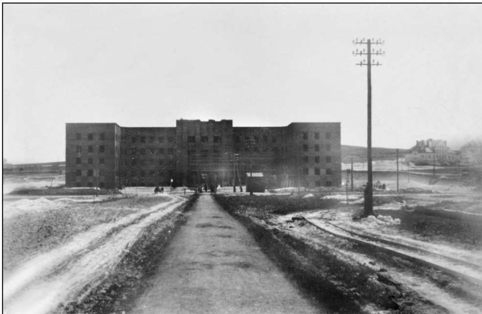
Fot. 15. Gmach Dyrekcji Kolejowej w budowie. Lata 30. XX wieku. Zbiory Wojewódzkiego Urzędu Ochrony Zabytków w Lublinie Delegatura w Chełmie.
