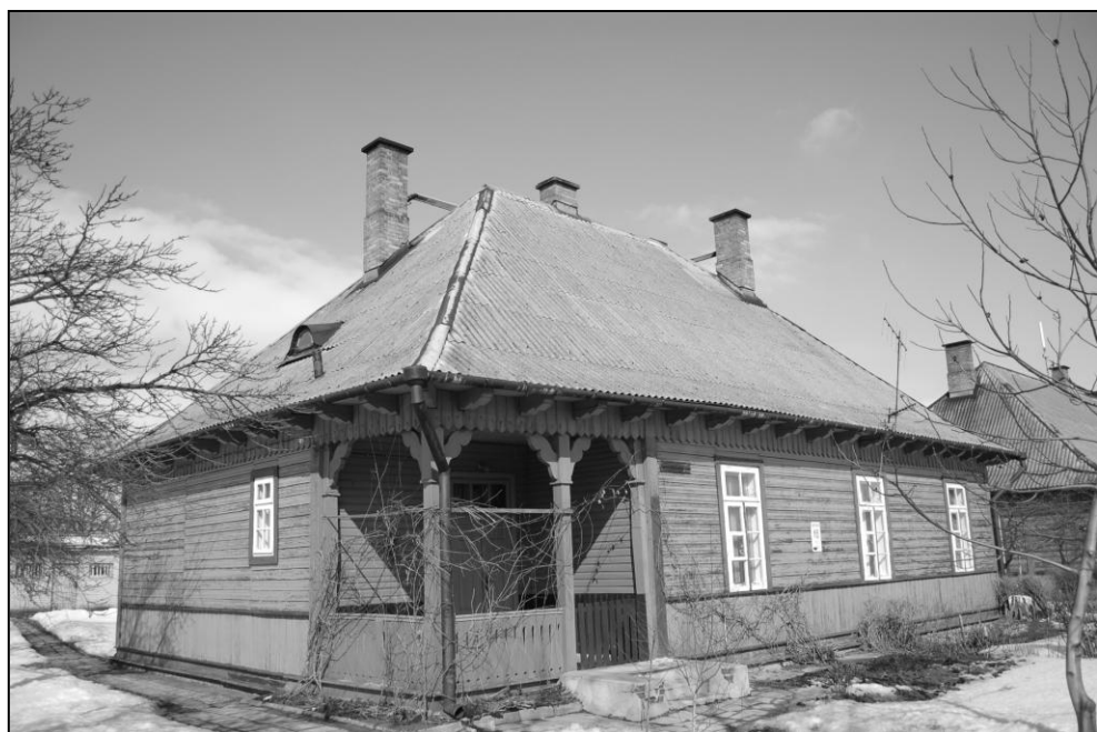
Ryc. 12. Ulica Żwirki i Wigury – drewniane domy budowniczych osiedla.
