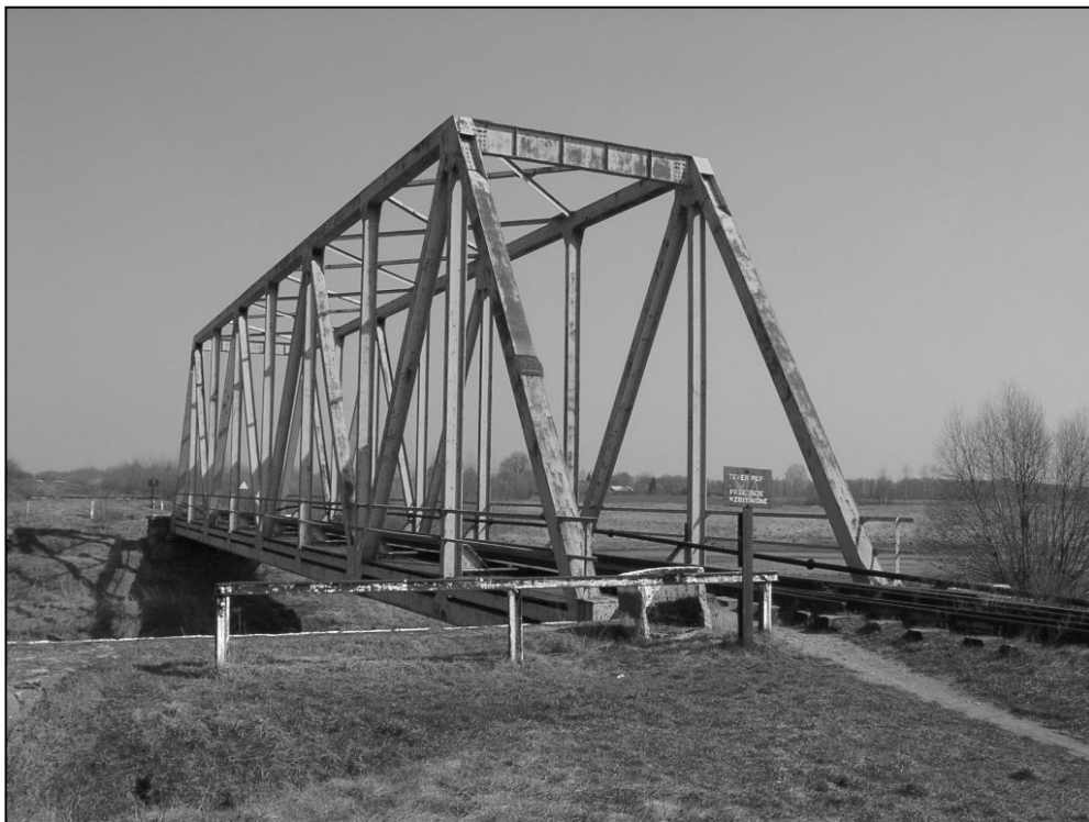
Ryc. 2. Rudka, linia kolejowa Chełm-Włodawa (Brześć n/Bugiem) – most na rzece Uherka.
