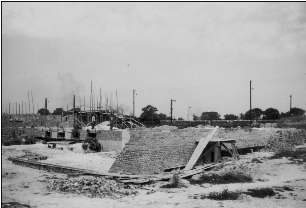
Fot. 28. Budowa dworca głównego Chełm. 1959 r. Zbiory prywatne Wiesława Wojasiewicza.
