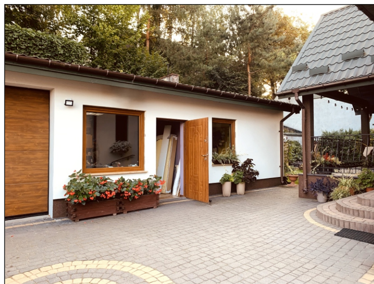
Nadmierne uszczelnienie powierzchni wokół domu to odcięcie wody dla roślin a w czasie deszczu problem z jej odprowadzaniem.
