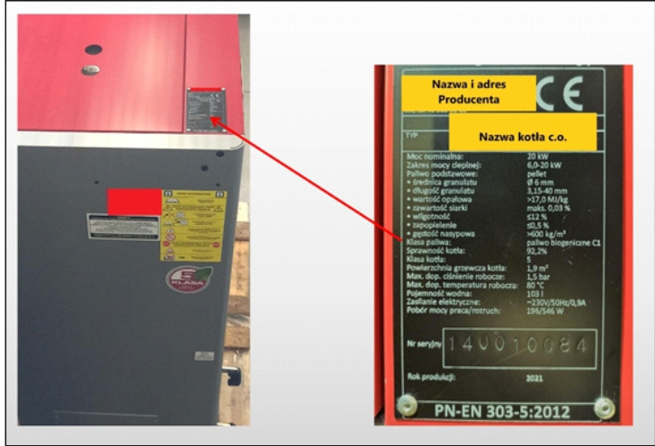
Przykład oznaczenia klasy emisyjności kotła.
