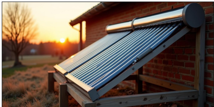
Kolektory słoneczne wykorzystywane do podgrzewania wody bytowej
